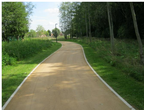
Recreatief wandel- & fietspad met verharding in met vulkanische toeslagstof gestabiliseerde siersteenslag
