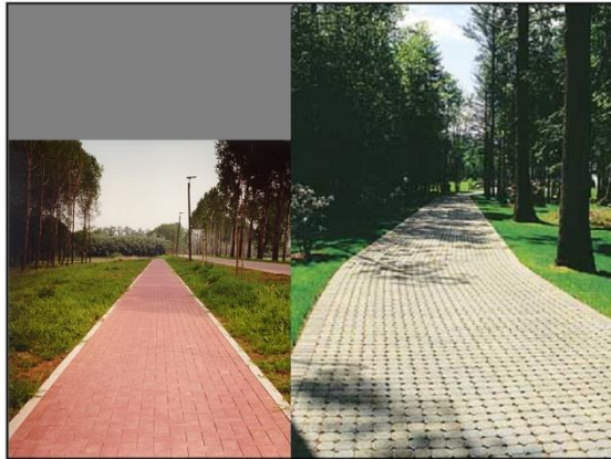
Paden aangelegd in betonstraatstenen
