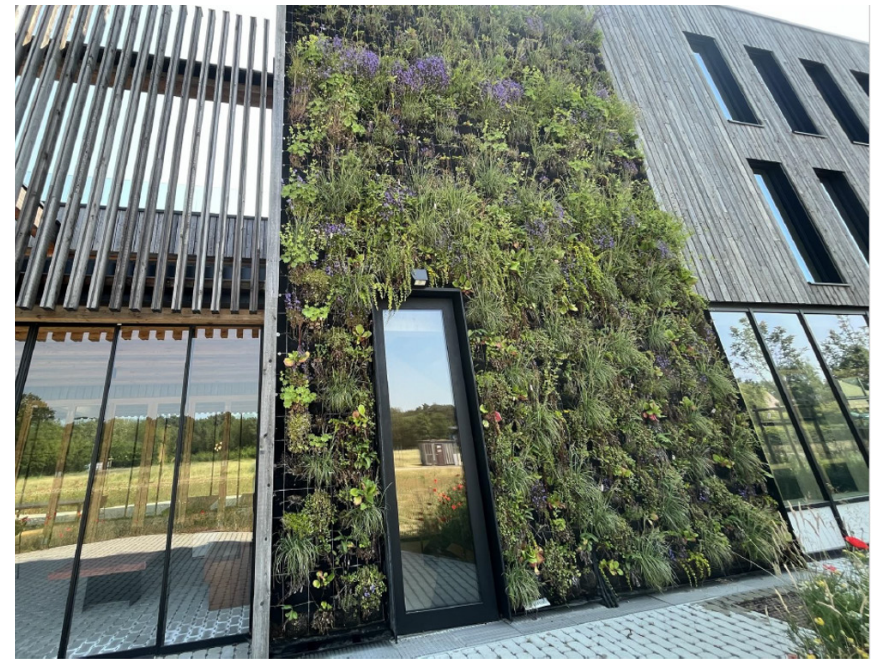
Figuur 13 Total Value Wall in kantoorgebouw, 't Centrum - Kamp C
