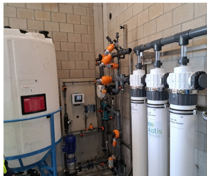
Figuur 24 Ultrafiltratie in Keiberg-Vossem
