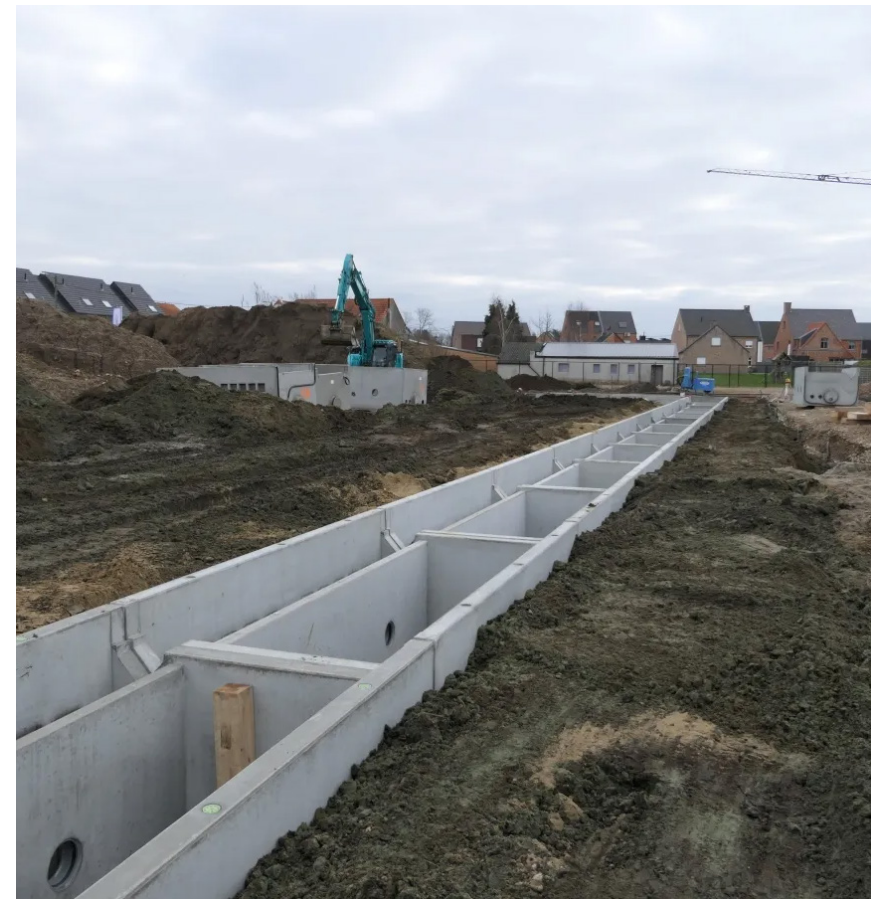
Collector in aanleg in Heist-op-den-Berg. In maart - april 2024 worden de nutswerken ingebouwd.
