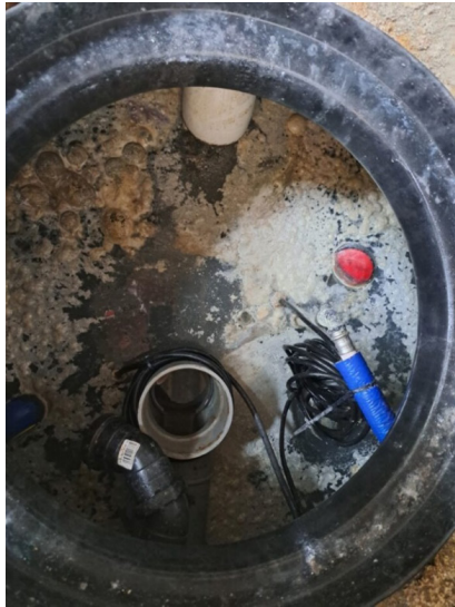
Figuur 11 Ongezuiverd grijs water voor behandeling door Total Value Wall in privé woning, Mortsel
