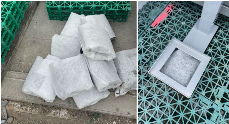
Geotextiel filterzakken (links) zijn in de verdeelkamers (rechts) gemonteerd om te voorkomen dat vuil in de regenwaterafvoer terecht komt
