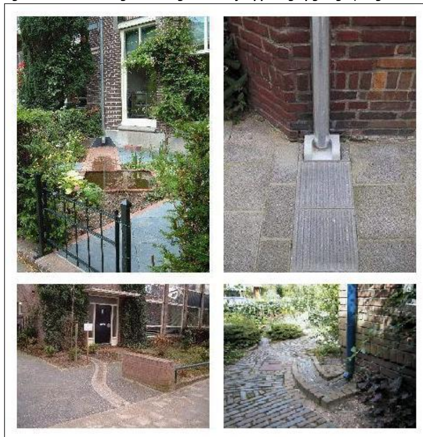
Figuur 1.3: Bovengrondse afvoergootjes
