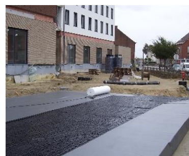
Ondergrondse Infiltratie-units
